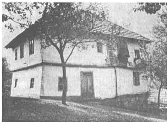
Stambena zgrada - "čardaklija"
