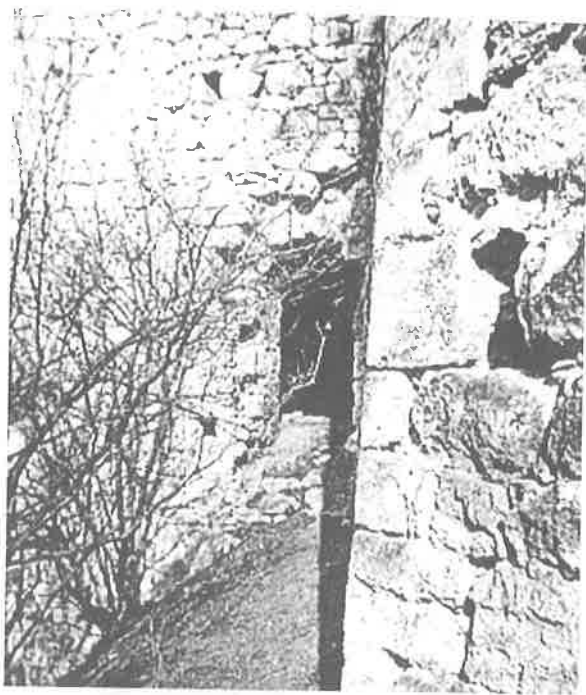
Sl. 8. Ulazna kula - pogled izvana
