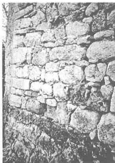
Sl. 5. Ulazna kula - način zidanja, prva
