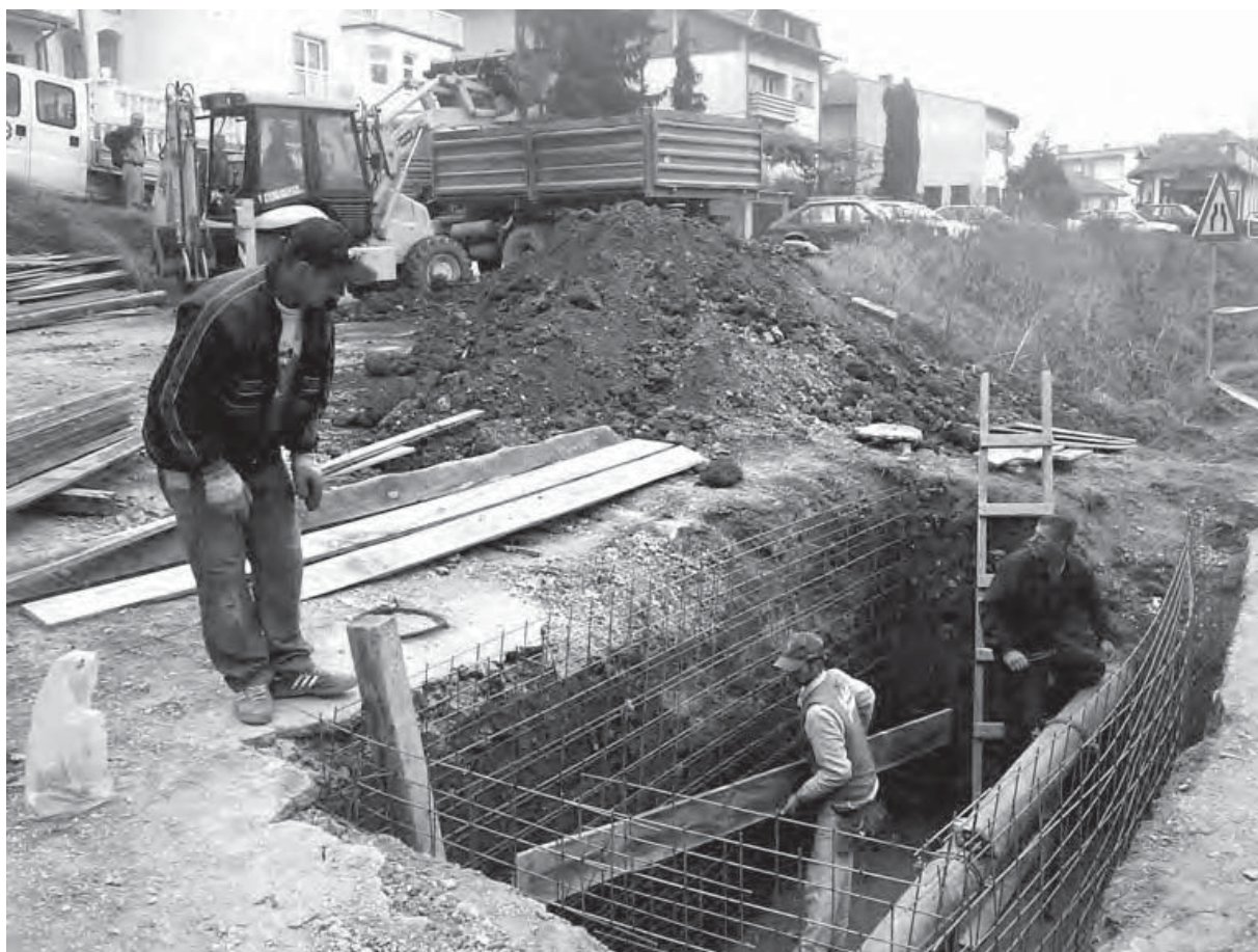
Slika 3. Izgradnja reducir stanice za automatsku kontrolu pritiska u Gračanici
