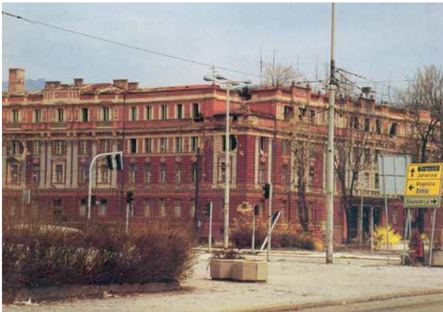
Zgrada Skupštine grada tokom agresije. U njenom podrumu su se nalazile prostorije Centra veze
