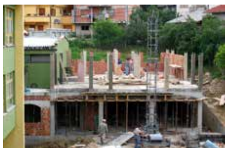
Izvođenje radova na novom objektu muzičke škole
