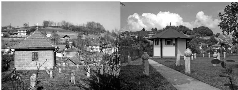
Šeh Dedino turbe – izgled prije i poslije zadnje obnove
