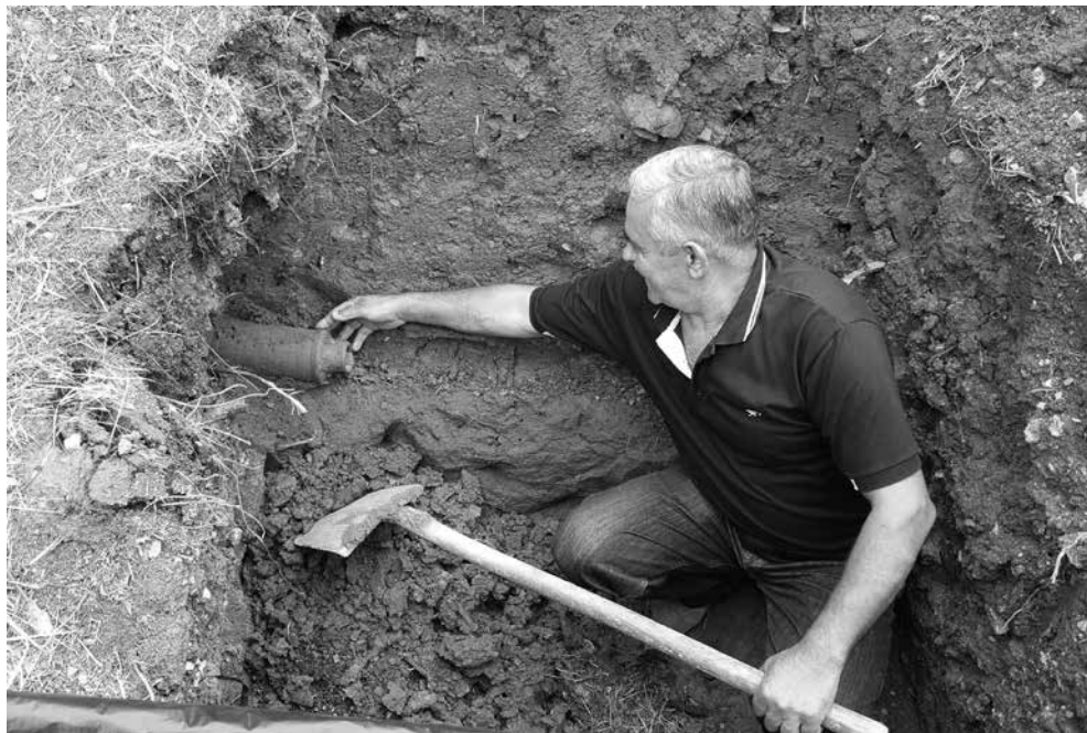
Slika 06: Stari vodovod na Drafnićima - prilikom iskopa
