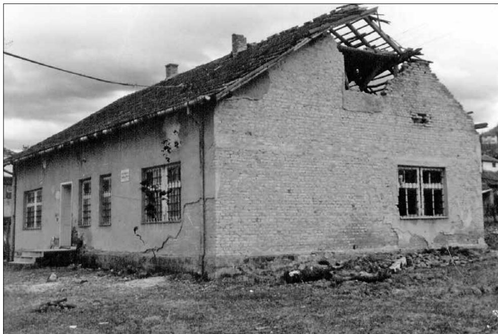
Posljedice granatiranja Lukavice - oštećeni objekt mjesne ambulante
