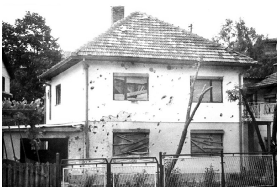
Posljedice granatiranja - oštećena kuća
