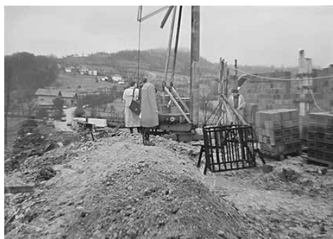
Građevinski radovi na izgradnji SOS Dječijeg sela (jesen 1996)
